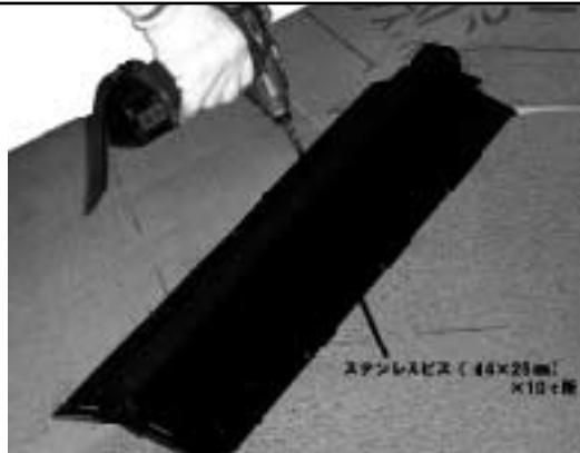
③隅棟用アルミ換気部材を所定の位置にセットし、ステンレスビス(φ4×L25mm)にて固定します。この際、隅棟芯と隅棟用アルミ換気部材の中心を合せ、隅棟用アルミ換気部材裏面シーラーと野地板の隙間が無くなる様にきっちり押えて固定して下さい。
