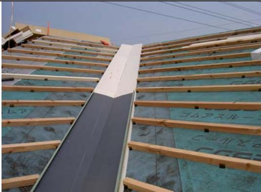
⑪谷板金を谷用断熱材の上に置き、吊り子にて椼木に固定して下さい。
