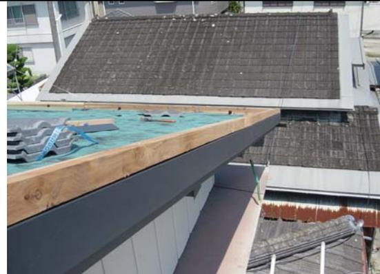
⑤断熱工法用軒先ケラバ水切をケラバ下地材に固定し、その上に登梁木 45×45(45×45)を固定して下さい。
