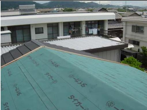
④ケラバ下地材 45×35(50)をケラバ部分にステンスビス 65 mm(75 mm)にてピッチ 600 mm以内固定して下さい。
