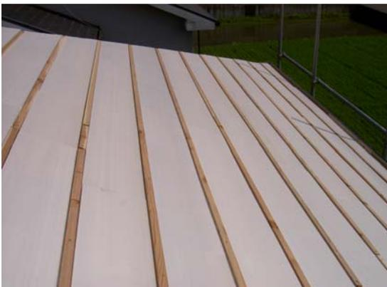
⑫断熱材は、軒先2段目より水下から水上に向かって施工します。断熱材を椼木間にはさみ込み受け金具付近の断熱材を手や足でたたみ込み断熱材を金具に取付けます。断熱材は隙間ができない様施工します。軒先1段目は室内の外側の位置にあり、特記がない限り施工は不要です。
