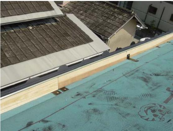
②軒先瓦座 30×65(80)×2,000 にL型軒先金具 3 個以上（ピッチ 900 mm以内）を引っ掛けるようにステンスビス 25 mmにて固定して下さい。固定後、野地板の先から 60 mmの位置に外づらを合わせてセットし野地板にステンスビス 25 mmにて止め付けて下さい。
