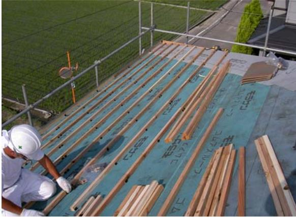
⑥墨打ちは、表に示す寸法で行って下さい。棟際は棟金具の幅を残して、墨打ちして下さい。
