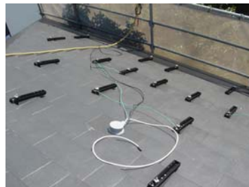
屋根上への配線
