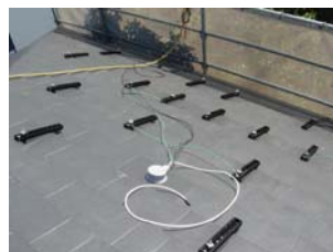
屋根上への配線
