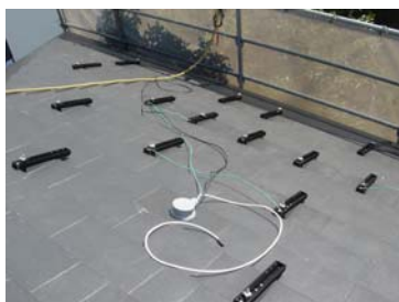
屋根上への配線
