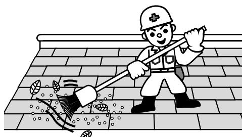
③作業中、足場から屋根面へ飛びおりたり、物を落したりするとヒビ割れ、破損を生じ、雨漏り等クレームの原因となりますので注意して下さい。
