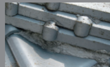
従来工法の漆喰処理
