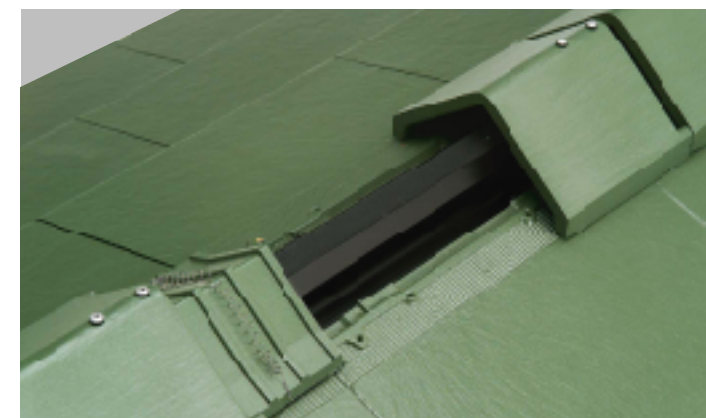
3. 換気棟瓦の取り付け
