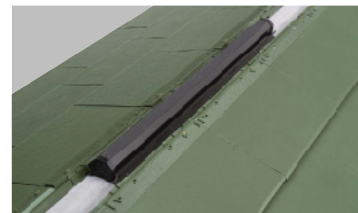
2. アルミ換気部材の取付 (4-25ビス 6本/個)
