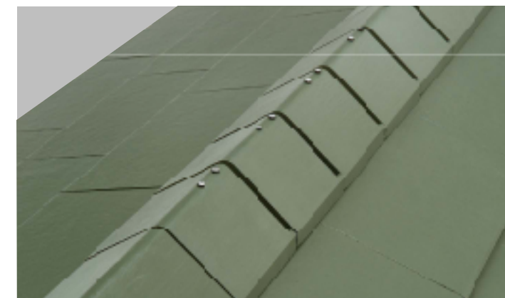
4. 周辺部の棟瓦の施工
