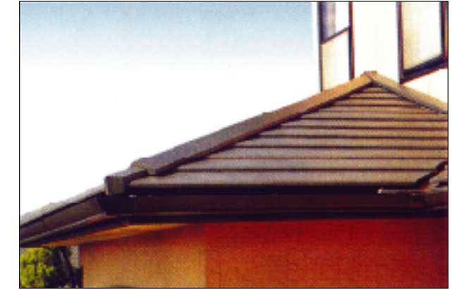
■三角棟瓦使用
