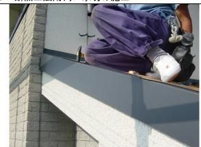
④断熱工法用軒先ケラバ水切を桟木に固定して下さい。
