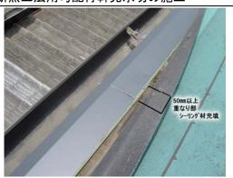
①断熱工法用勾配付軒先水切を、野地板とルーフィングの間 にカラーネイル釘 L32 mmにてピッチ 600 mm以内で取付けて下 さい。軒先水切の重ね代は、50 mm以上とし、重なり部 にシーリング材を充填して下さい。
