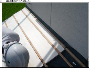
⑤棟際と同じく、瓦割りができない場合、断熱材をカットし、 隙間ができた場合現場発泡ウレタンフォームを充填して下さい。また、壁際流れ方向には捨水切を先に入れておい て下さい。
