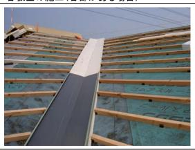
⑨谷板金を谷用断熱材の上に置き、吊り子にて桟木に固定して下さい。
