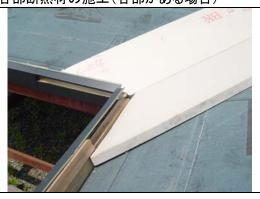
⑦屋根に谷部がある場合、軒先瓦座を断熱材の厚みに 合わせて切り込みます。また、断熱工法用勾配付軒先 水切も谷板が軒先に巻けるように切り抜いて下さい。
