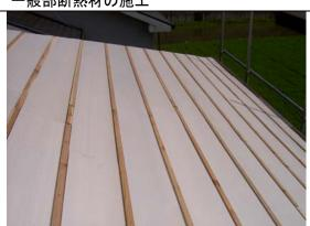
⑩断熱材は、軒先 2 段目より水下から水上に向かって施工します。断熱材を桟木間にはさみ込み受け金具付近の断熱材を手や足でたたみ込み断熱材を金具に取付けます。断熱材は隙間ができない様施工します。
