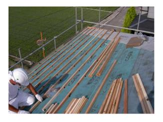
④墨打ちは、表に示す寸法で行って下さい。 棟際は棟金 具の幅を残して、墨打ちして下さい。
