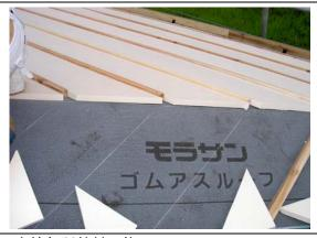
①隅棟部には、あらかじめ斜めカットされている「隅棟部用斜めカット断熱材」を使用して下さい。「隅棟部用斜めカット断熱材」は、屋根勾配 4.5 寸に合わせ切断しています。 4.5 寸以外の勾配の場合、できる限り隙間が小さくなる様施工して下さい。
