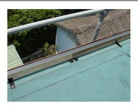
②軒先瓦座 30×65(80)×2,000 にL型軒先金具 3 個以上 (ピッチ 900 mm以内)を引っ掛けるようにステンレスビス 25 mmに て固定して下さい。固定後、野地板の先から 60 mmの位 置に軒先瓦座の外づらを合わせてセットし野地板にステン レスビス 25 mmにて止め付けて下さい。
