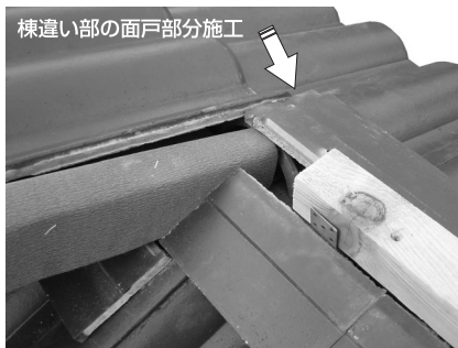
防水シートをカット袖施工の部分を隙間無く防水シート施工
