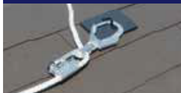
親綱取付状況
