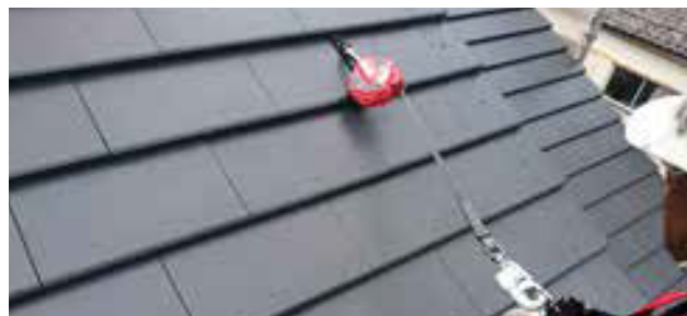
瓦屋根安全金具使用状況写真
