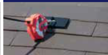
安全ブロック取付状況
